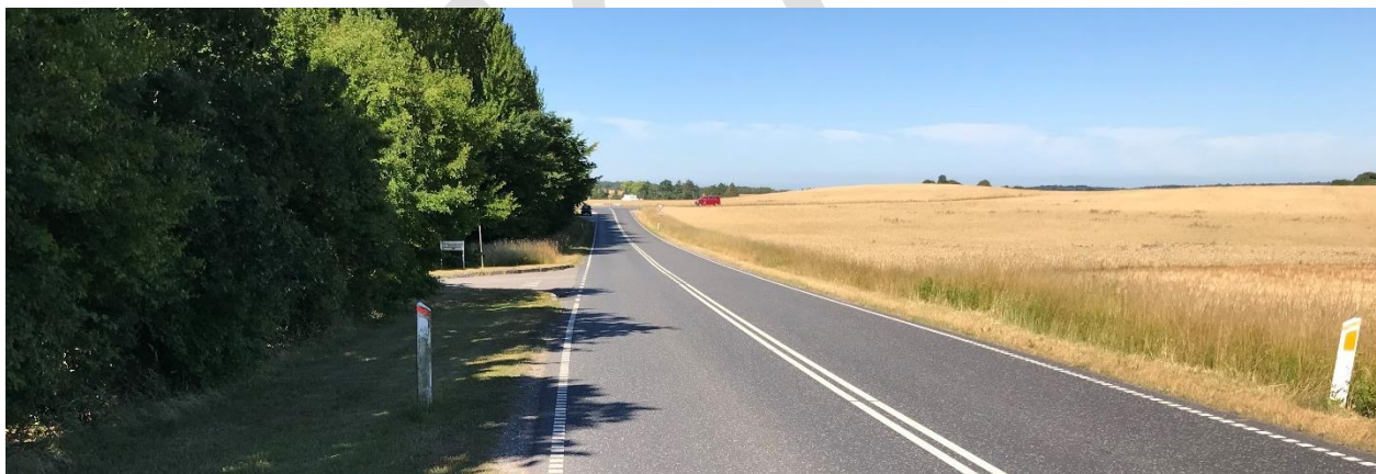
Figur 2. Kollerødvej, set fra øst i retning mod Mejeribakken (til venstre).
