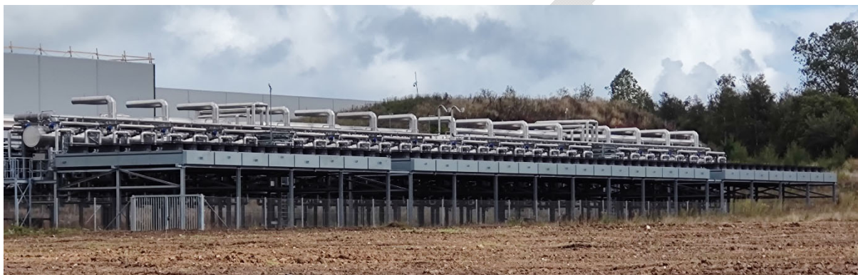
Figur 21 - Kølegården til varmepumpen ved Farum Fjernvarme
