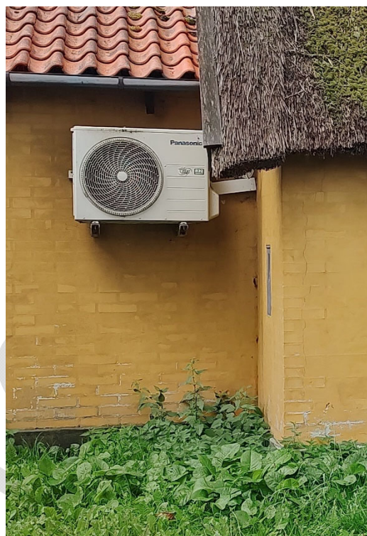
Figur 25 - Udedel fra en luft-til-luft varmepumpe. Udedelen til en luft-til-vand varmepumpe er typisk lidt større og placeret på jorden ved siden af huset.
