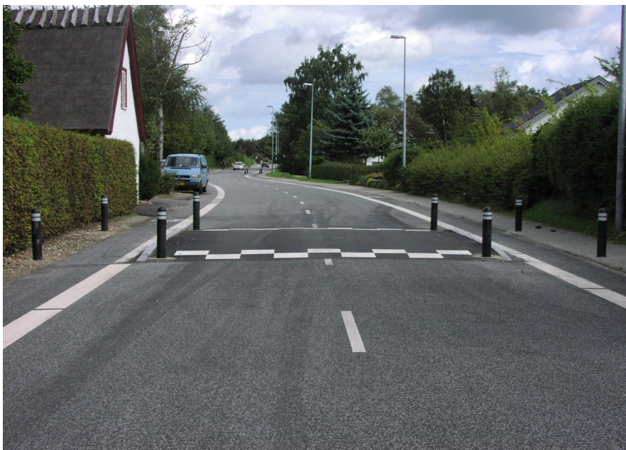
Figur 1: Bump på Røglevej
