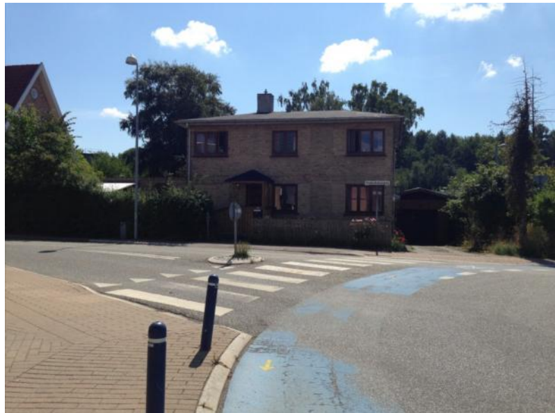
Slidt markering i rundkørslen Frederiksborgvej/Amtsvej
