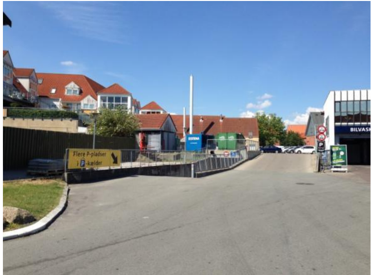
Den ensrettede nedkørsel til p-kælderen der måske kan vendes.
