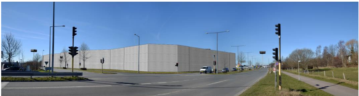
Figur 10.3 Fotostandpunkt 1, set fra Herredsvejen væk fra Hillerød centrum. Afstanden til det ansøgte butikscenter er ca. 40 m. (variant). Højden for centret er sat til 17m.
