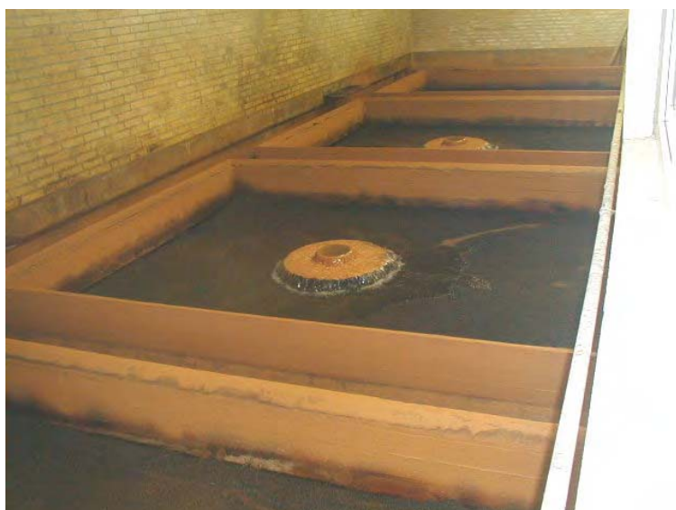
Figur 5. Forfilter på Lillerød Vandværk
