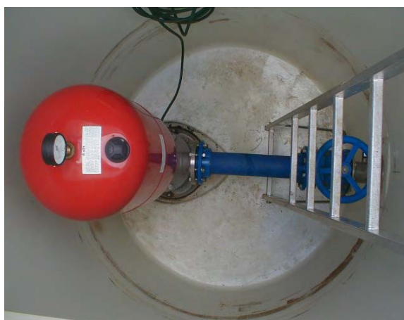
Figur 7. Boring på Uggeløse Vandværk
