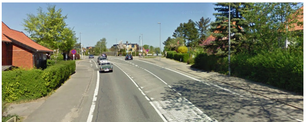
Figur 7. Delstrækning 4. Bemærk buslommen til venstre i billedet og det meget brede tværsnit op til krydset med Kærhøjgårdsvej.
