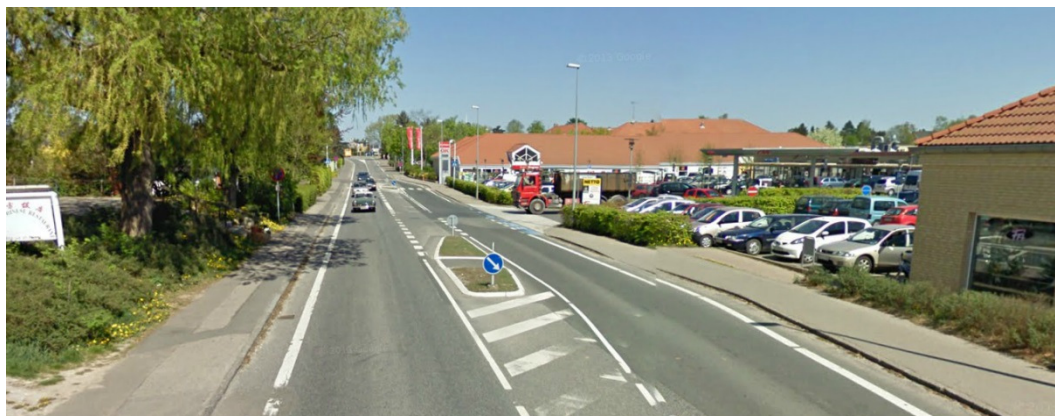
Figur 6. Delstrækning 3. Vejen er på denne strækning bredere pga. venstresvingskanalisering.
