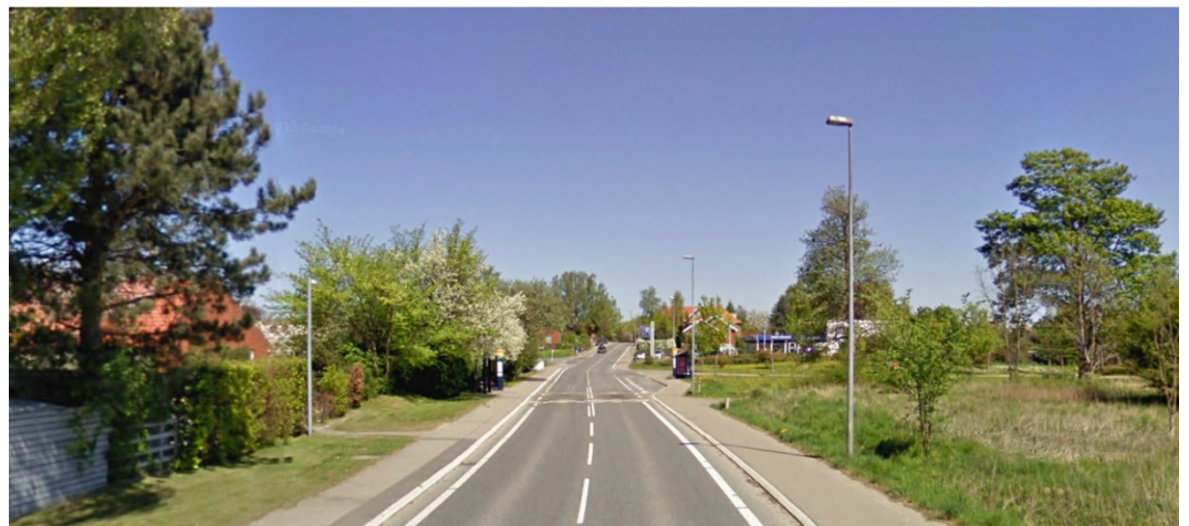
Figur 4. Delstrækning 1. Bemærk buslommen i vejens højre side.
